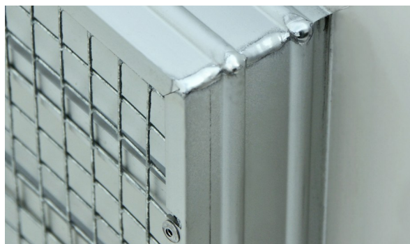
Trafo Ventilasjonsrist sett fra baksiden
